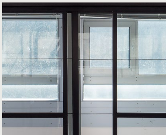
Materialåterbruk i fokus vid hyresgäst Anpassning i fastigheten Söderhällby i Uppsala
