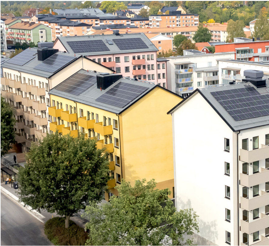
Projekt Korsängen med bostäder i centrala Enköping färdigställdes under det fjärde kvartalet 2024.
