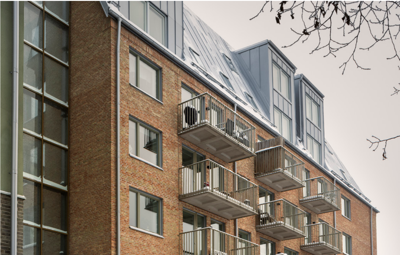
Projektet Segerdal är beläget i centrala Knivsta i direkt anslutning till tågstationen. Det första kvarteret har färdigställts och hyresgästerna har flyttat in. Det andra kvarteret, som är i produktion och färdigställs i november 2025, innehåller 151 lägenheter. Projektet genomförs i ett joint venture med Redito.
