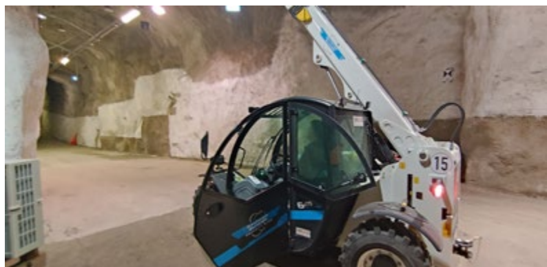
Bygget av Bahnhof Bunker är i full gång. Första kunderna flyttar in 2026.
