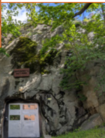
Bahnhof Bunker blir ett underjordiskt datacenter enligt militär standard.
