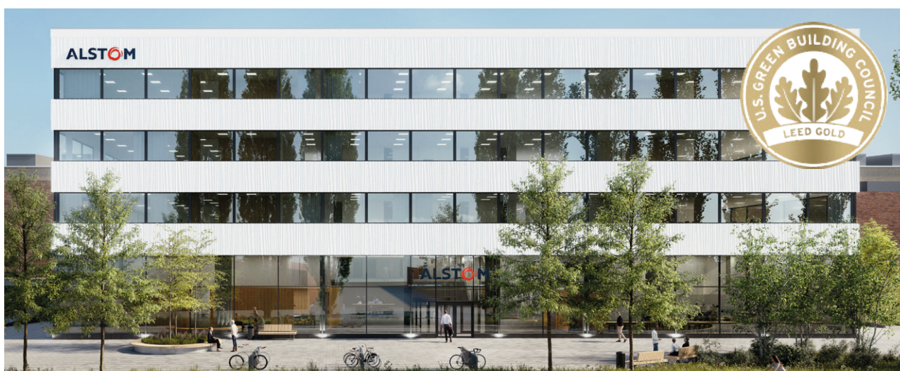
Pågående byggnation på Finnslätten 6, Västerås.
