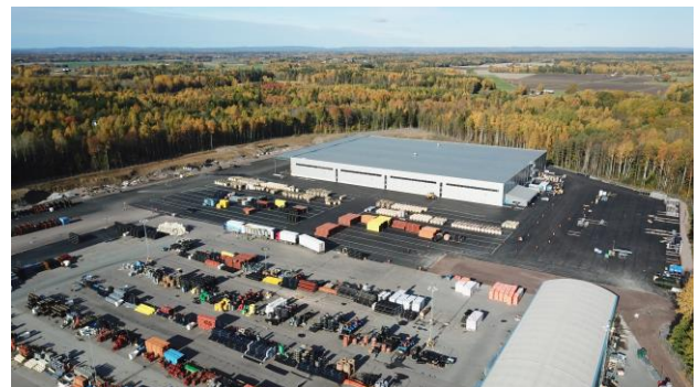
Den nya rörhallen i det svenska logistikcentret invigdes i oktober.
