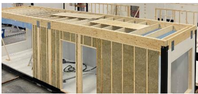
Modul under byggnation i fabrik
