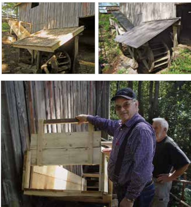
Nu har även vattenhjulet fått ett stickspåntak och en fullt fungerande vattenränna. Stig Olsson visar stolt upp arbetet. I bakgrunden står Gunnar Johansson från hembygdsförening som hjälpt till med renoveringen.
