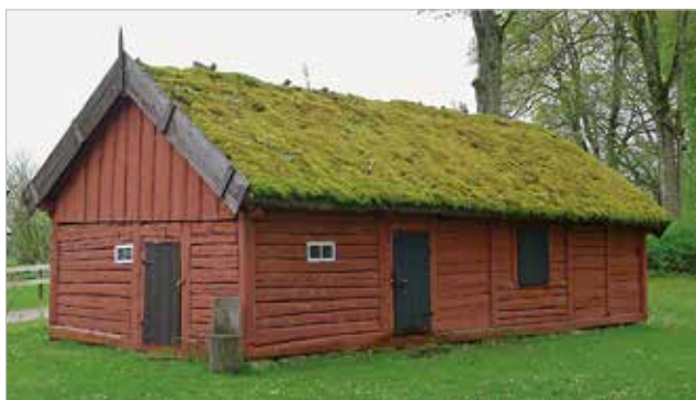
Den lilla ryggåsstugan före och efter takomläggningen. De nya vindskivorna målades med falu rödfärg.
