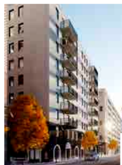
Byggstart för projektet Sländan – det största i Södertälje på 40 år.
