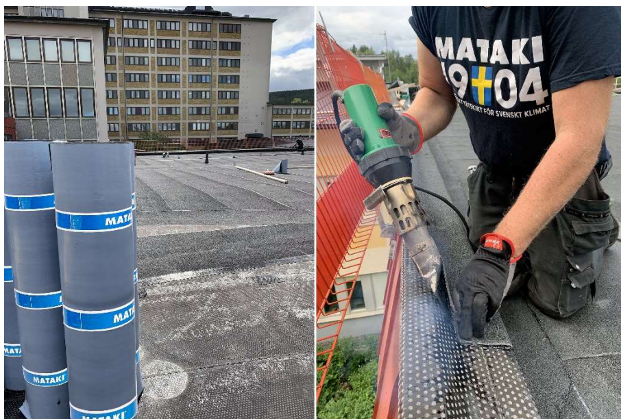
Mataki rekommenderade en varmluftsinstallerad tvålagstäckning för en säker och tålig installation. Foto: Mataki
