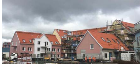
Kv. Luftseglaren 2, mars 2019.
