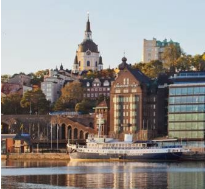
Sjömansinstitutet i Slussen. Foto Erik Lefvander
