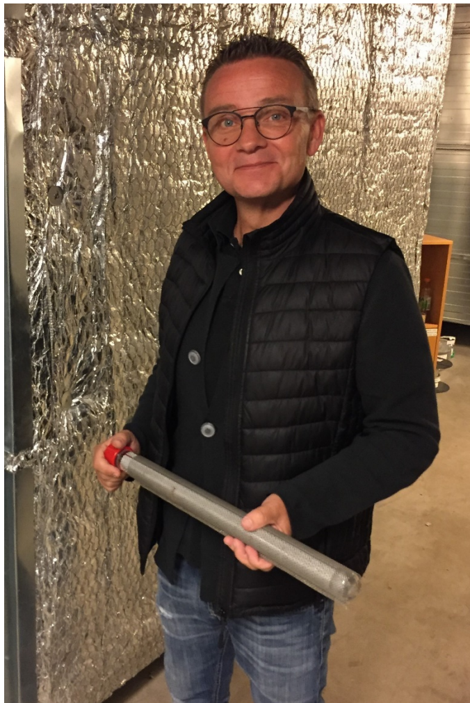
Morgan Westlund, fastighetschef för Göteborg på Atrium Ljungberg, med ett joniseringsrör. Foto: Atrium Ljungberg
