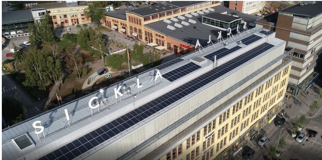
Stockholms största solcellsanläggning finns i Sickla. Bild: Atrium Ljungberg
