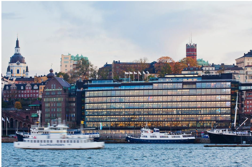
Glashuset, Slussen. Foto: Erik Lefvander
