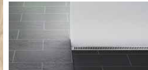
Bad, Evers gulvfliser og Unidrain-system
