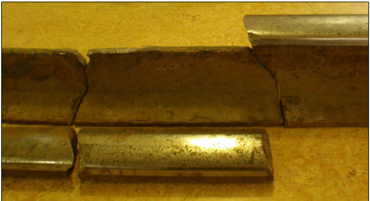
Bilden visar sprickor i räl från aktuell plats.
