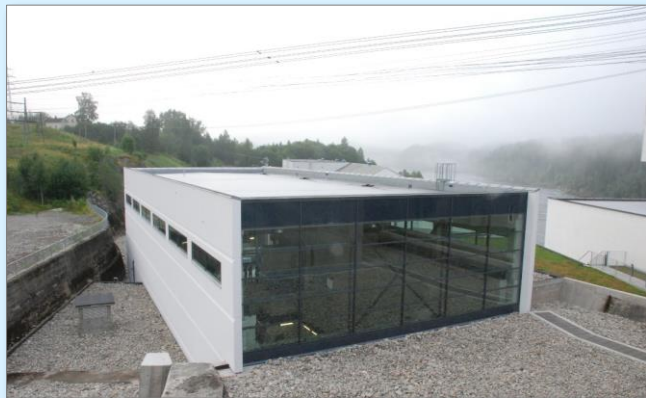
Nytt aggregat i Kykkelsrud - 2011
