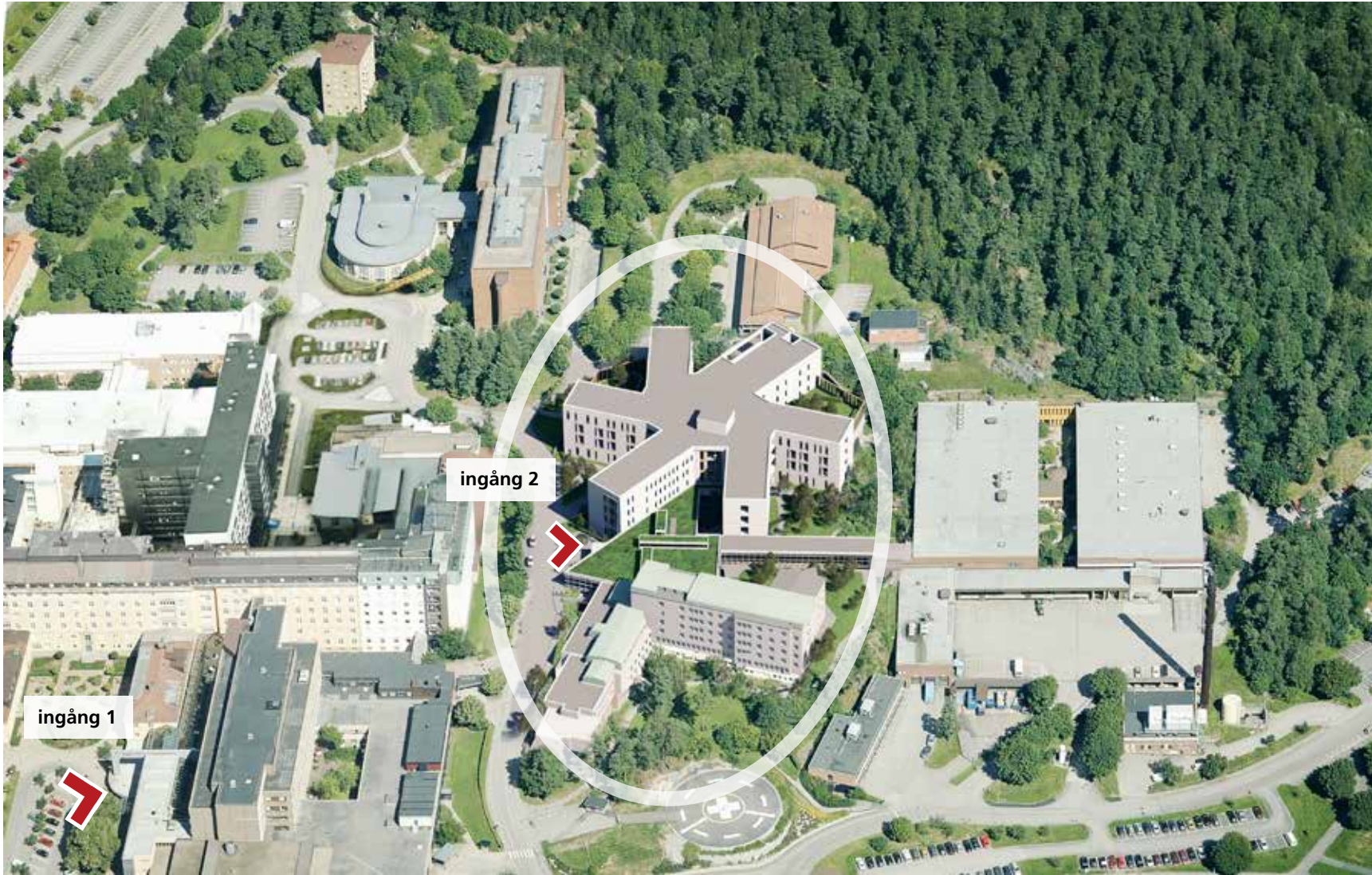
Sjukhusområdet med huvudentré (ingång 1) och entré till psykiatrins kvarter (ingång 2).
