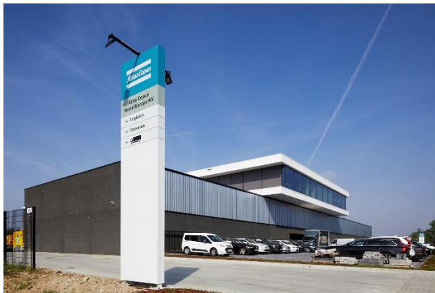
Den nya anläggningen i Boom, Belgien
