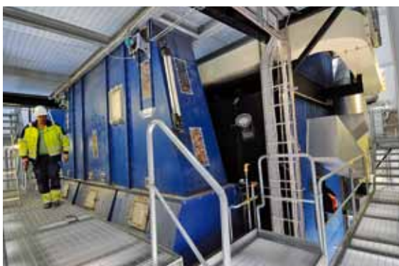
En Saxlundugn i en biobränsleanläggning.
