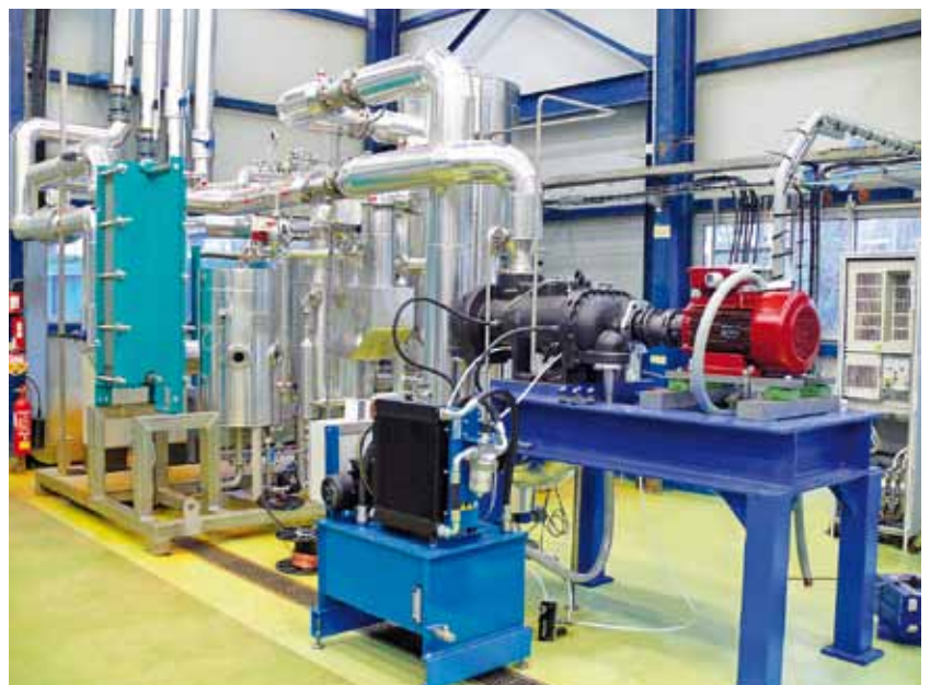
Kompressor från Opcon/SRM i en av energibolaget EDF:s värmepumpanläggningar i Frankrike.
