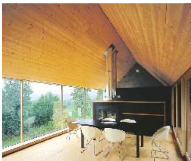
I villan Dysthe/Lyngstad tillåter massivträkonstruktionen en helt öppen fasad ut mot dalen. Foto: Knut Hjeltnes.
