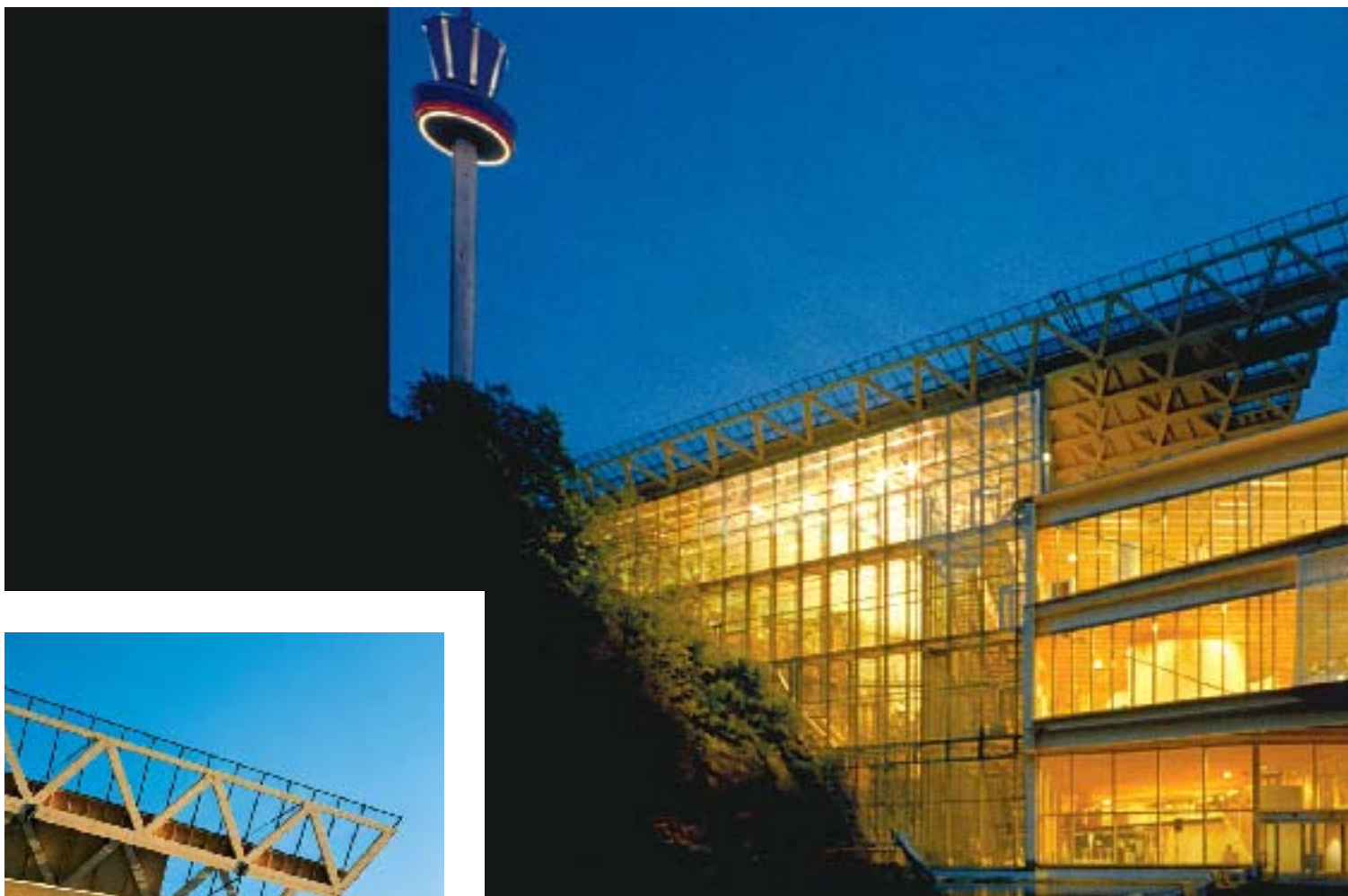
Limträkonstruktioner i Universeum i Göteborg.
