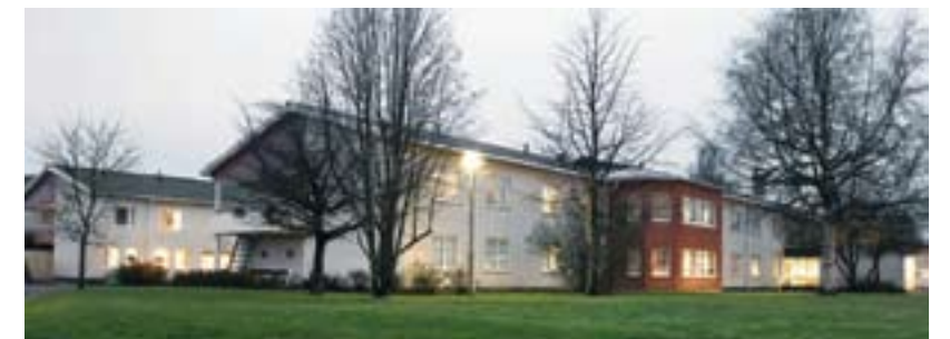
Moelven Årjäng Säg AB levererar fjärrvärme till Årjängs kommun via sin fjärrvärmeanläggning på sågverket. Kvarnäsens äldreboende är en av institutionerna som värms upp av miljövänlig energi i form av flis och bark. Moelven har startat en större satsning på bioenergi som verksamhetsområde.
