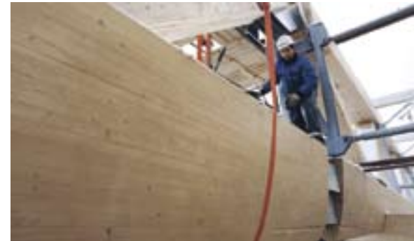
1995 – Bärande konstruktioner till Gardermoen levereras i limträ.
