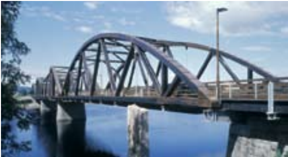
Industriträ från Timber används som insatsvara i produktionen av limträ. Bilden visar limträkonstruktioner från Flisa-bron över Glomma.
