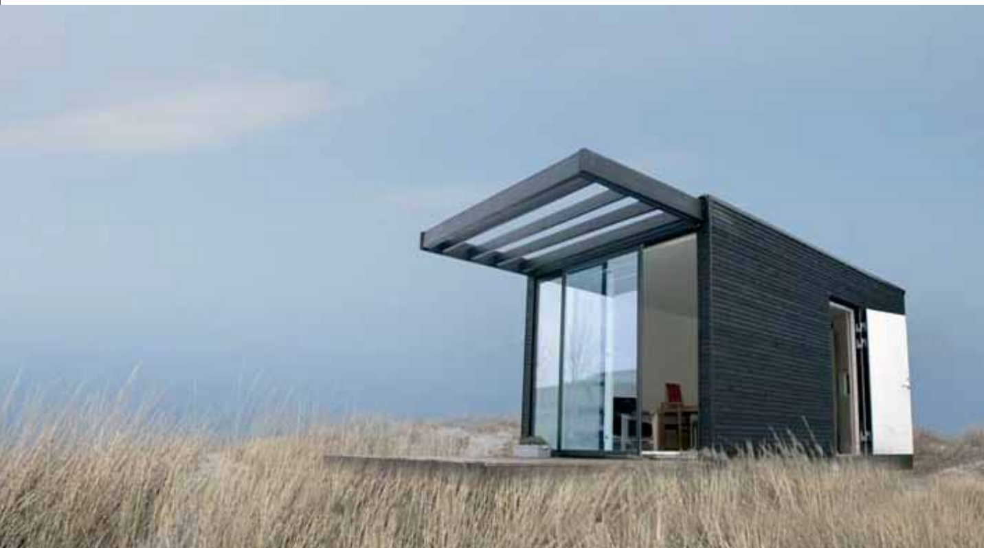
Minihuset ONE+ på 15 kvadratmeter byggs som prefabricerade moduler av organiskt impregnerad svensk gran. Arkitekt: Lars Frank Nielsen, tillverkare: Add-A-Room, Tyresö, Sverige.
