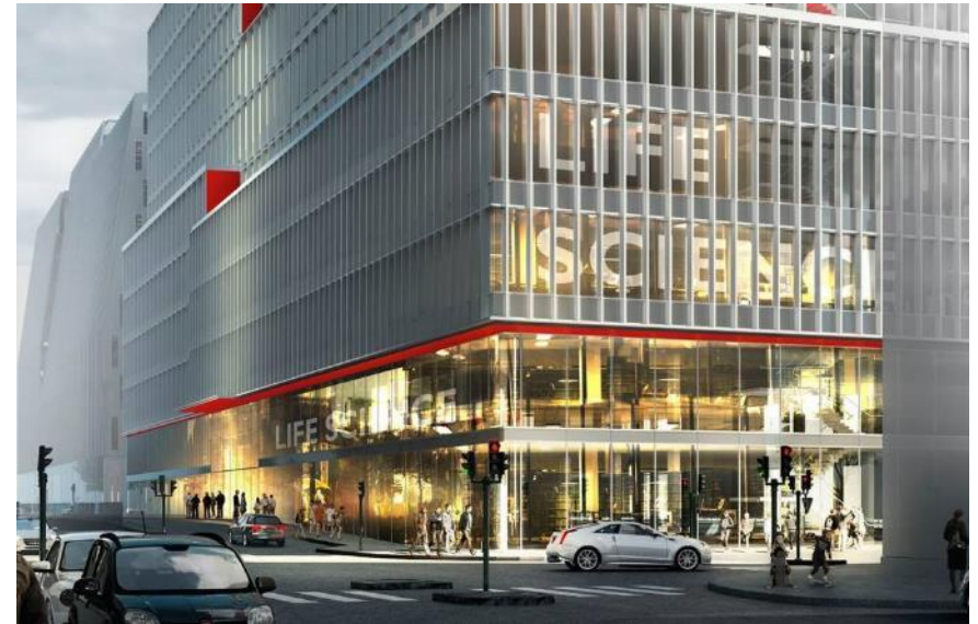
Veidekke bygger sykehusbygg nær Karolinska i Stockholm
