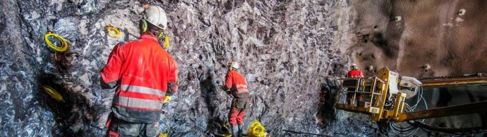
Pågående tunnelarbeid på RV80 ved Bodø
