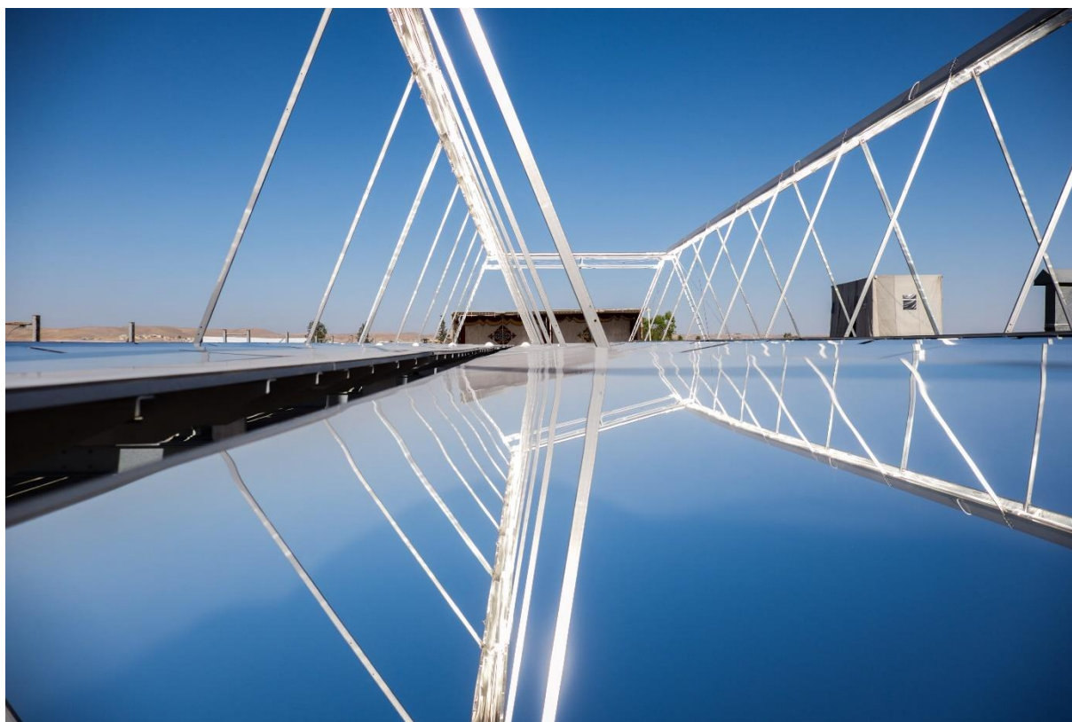
Industrial Solars installation med Fresnel-solfångare för produktion av industriånga hos RAM Pharma i Jordanien, 2015. Copyright: Industrial Solar GmbH/Anders
