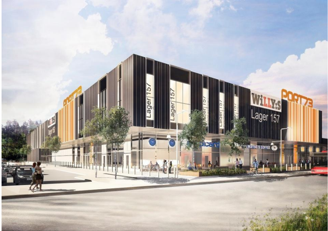
Den tredje etappen av Port73 invigs den 28 augusti med fler butiker och restauranger. Illustration: Nyréns Arkitektkontor
