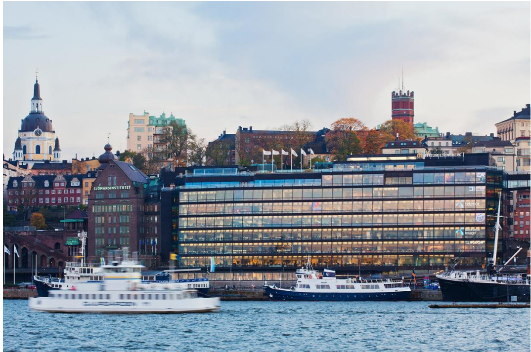
Glashuset, Slussen. Foto: Erik Lefvander
