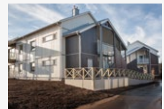
De fem nybyggda trähusen har sex lägenheter i varje huskropp fördelat på två våningar, totalt 30 familjelägenheter varav 10 fyror och 20 treor.
