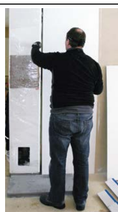
Kun hormi on paikoillaan, puretaan suojaukset ja tarkistetaan hormin suoruus sekä kiinnitys.
