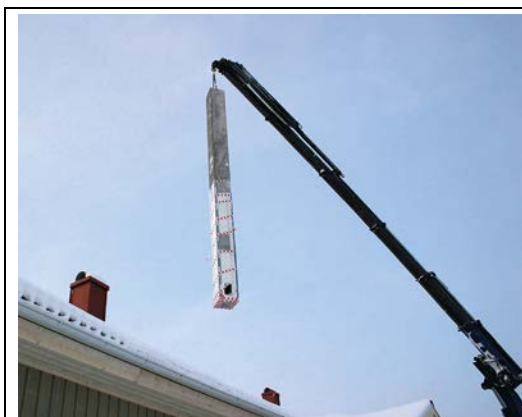
Hormi asennetaan kattoon ja välipohjaan tehdyn asennusaukon kautta kokonaisena paikoilleen.
