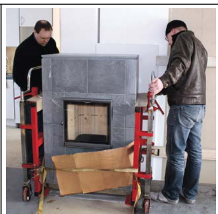
Tulisija tuodaan sisälle ja siirretään täsmälleen oikealle paikalleen. Hormiliitoksen sekä läpivientien eristys viimeistellään.
