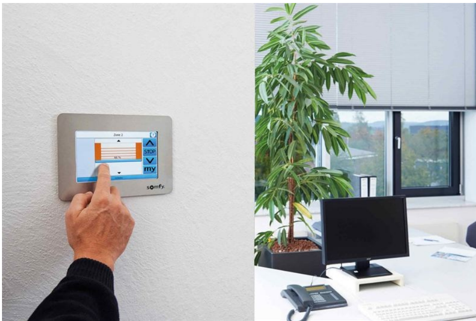
Bild 1: Flexibel und bedarfsorientiert: Mit der Sonnenschutzzentrale lassen sich jetzt bis zu acht Fassaden intelligent automatisieren.
